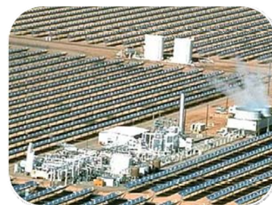
Kramer junction SEGS 计划的电力岛
